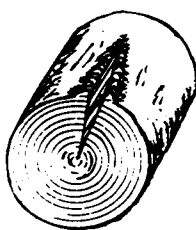
图5 冻裂和震击裂
